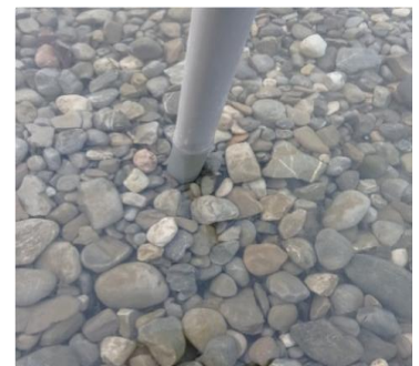
Injektion der Kiesbank
